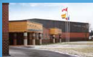
5 ÉCOLE CLÉMENT-CORMIER BOUCTOUCHE • Grades 9 - 12
